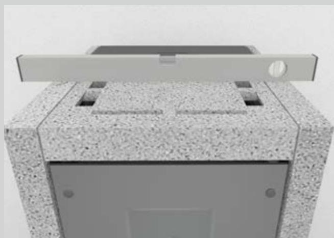
A l'aide du niveau à bulles adapté, vous pourrez contrôler si la plaque de pierre haute de finition est alignée à la bonne altitude et dans le même plan que le corps du foyer du poêle et les pierres d'habillage gauches et droites.
