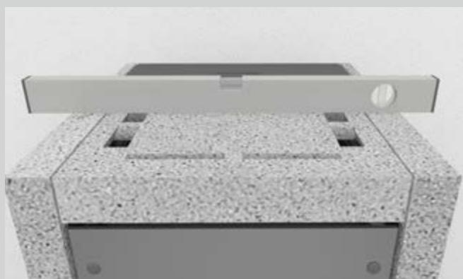
Con ayuda de un nivel de burbuja de aire puede controlar si la placa superior se encuentra a la altura correcta.
